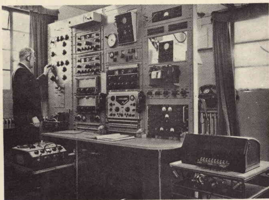
Fig. 2 - Sezione ricevente di un moderno Centro di Controllo per servizi marittimi. Alla destra è visibile la telescrivente.
