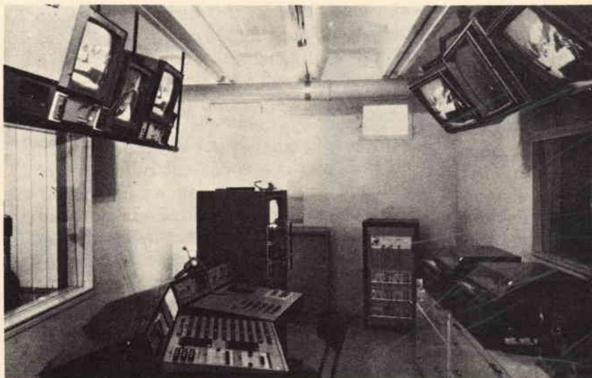
Fig. 9 - Sala di regia con banco di missaggio, apparecchiatura a «rack» per l'elaborazione dei segnali, ed una serie di monitori, con l'aggiunta di due video-registratori.
