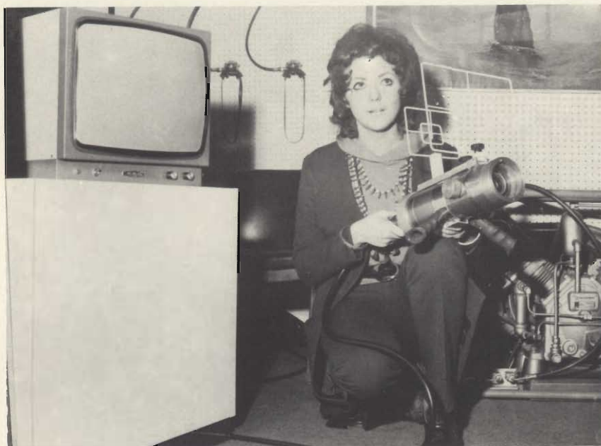
Fig. 6 - Complesso di televisione a circuito chiuso per riprese subacquee della LA PHOTOCINES-SUB - In alto a sinistra monitor G.B.C. da 17". In mano alla ragazza telecamera G.B.C. nella relativa custodia. Sullo sfondo è visibile il gruppo elettrogeno.
