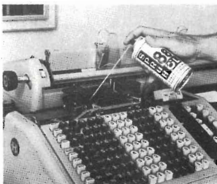
Fig. 13 - Impiego del prodotto denominato «Oil Spray 88» per la lubrificazione del carrello di una macchina da scrivere.
