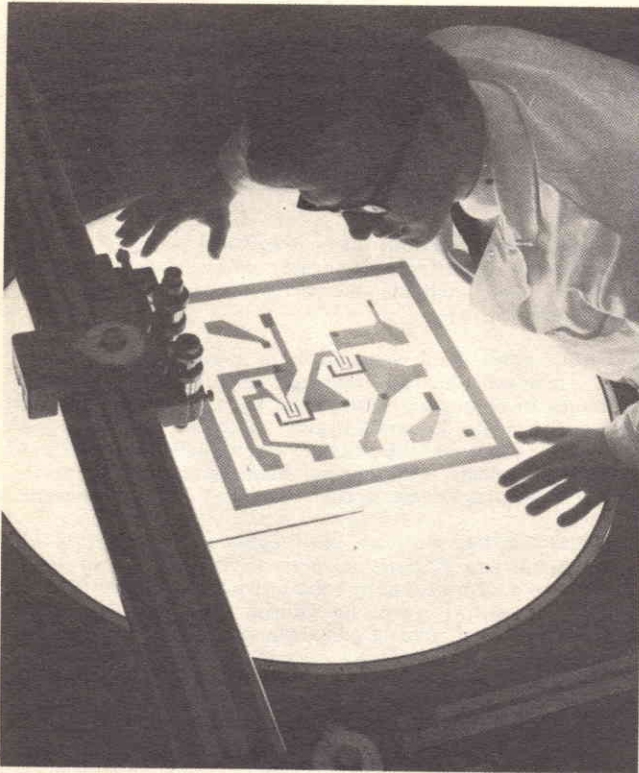
Fig. 84 - Controllo ottico della pellicola (master) ricavata dal disegno.
