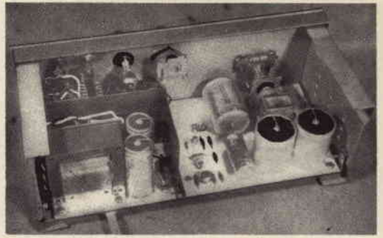
Fig. 4 - Il generatore montato visto dalla parte posteriore.
