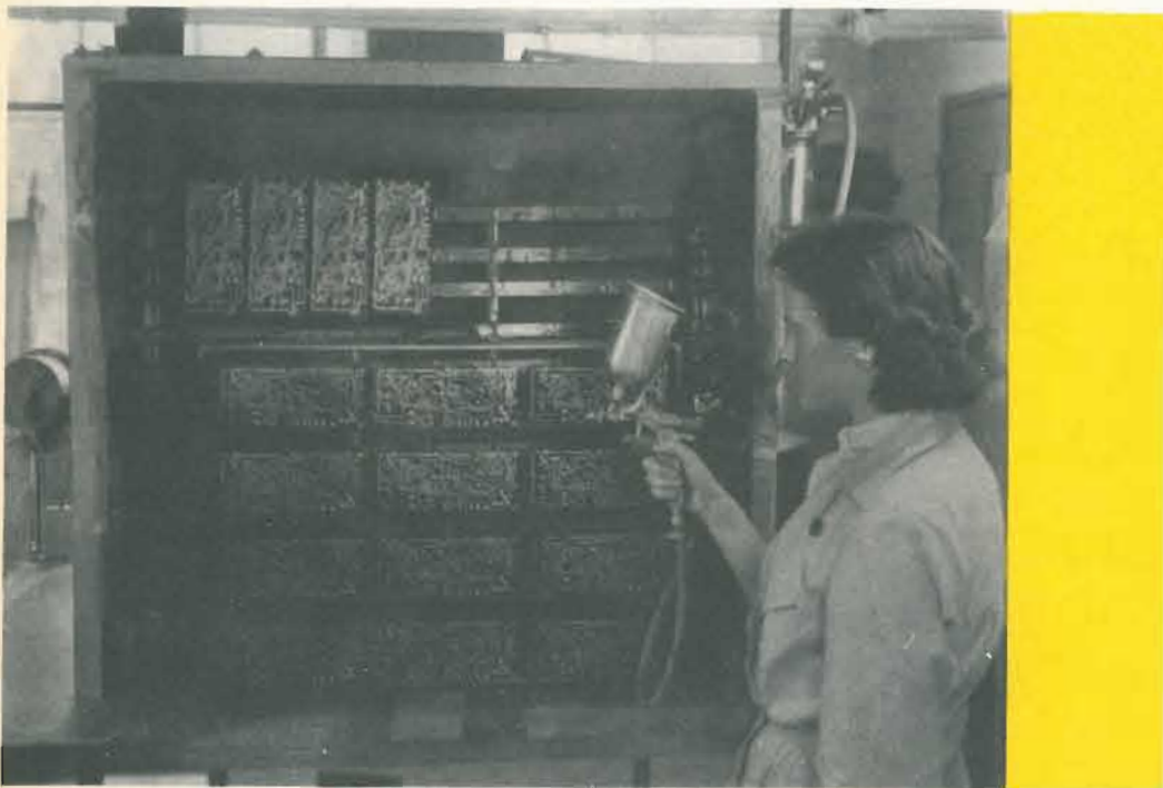
Flussaggio di pannelli a circuiti stampati, effettuato con areografo.
