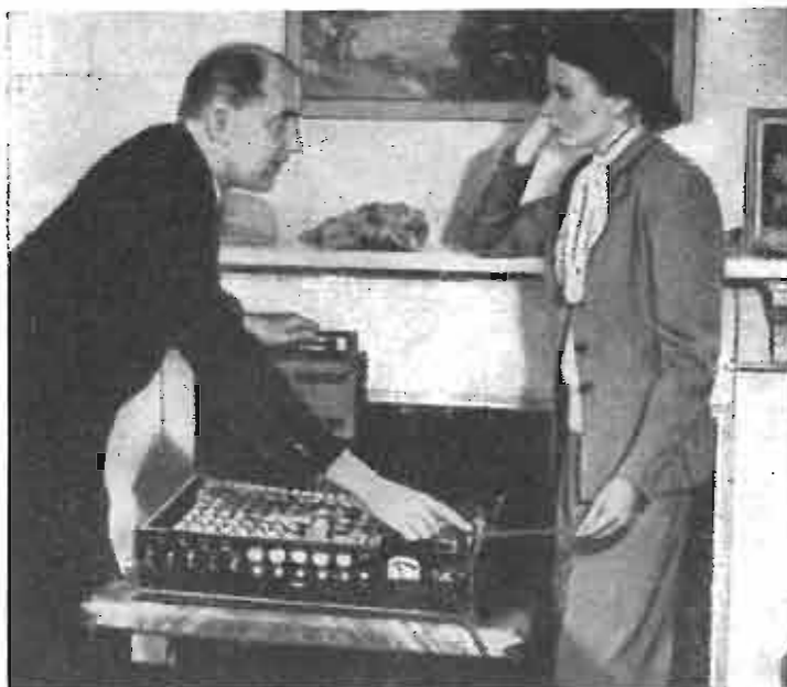
Questa è Simon, la più piccola calcolatrice elettrica esistente. Essa compie qualunque operazione in circa 2/3 di secondo. (Radio Electronics).
