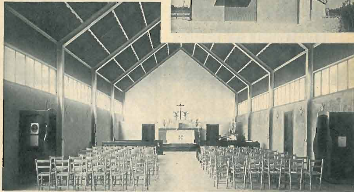
LA CHIESETTA PREFABBRICATA GIÀ APERTA AL CULTO NEL COMUNE DI SEGRATE
