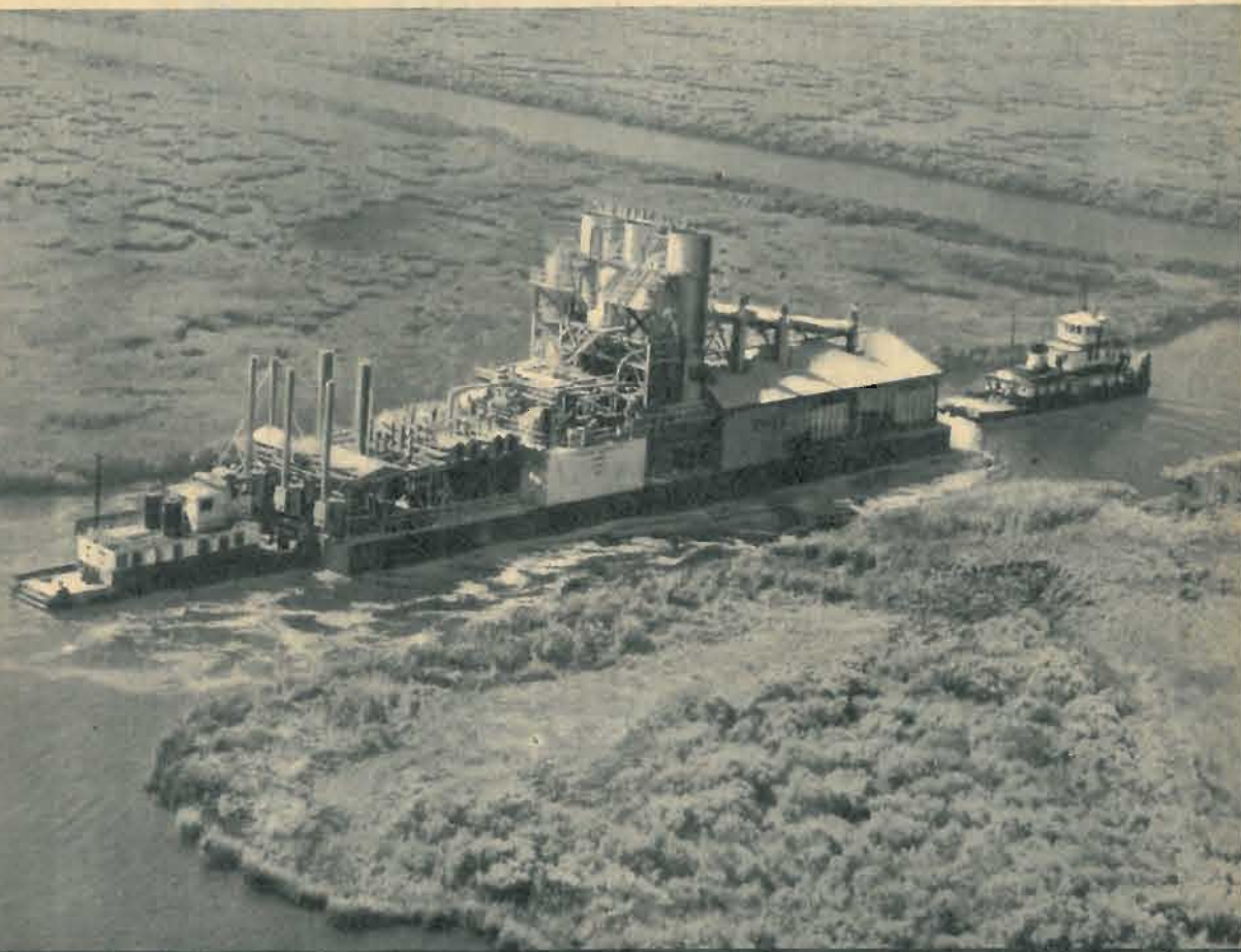
LA CENTRALE GALLECCIANTE E' RIMORCHIATA ATTRAVERSO I CANALI APERTI NELLA PALUDE
