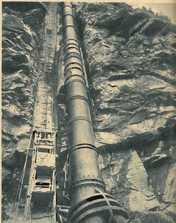
● Condotta forzata della centrale di Liro III in provincia di Sondrio. La lunghezza della condotta è di 223 m con un diametro di 2,27 m. La produttività dell'impianto è di 73,6 milioni di kWh.
