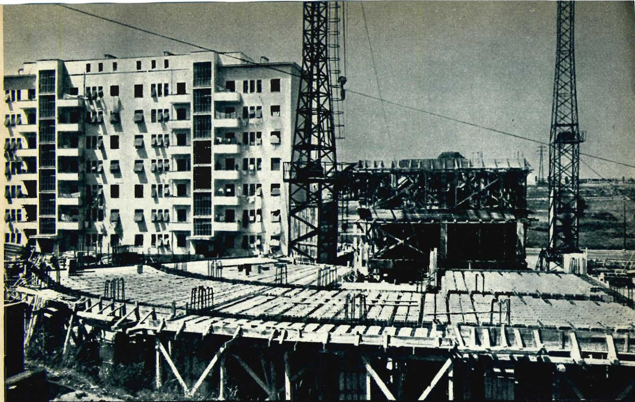
• Una veduta parziale del cantiere dell'Istituto Case Popolari alla Garbatella (Roma).
