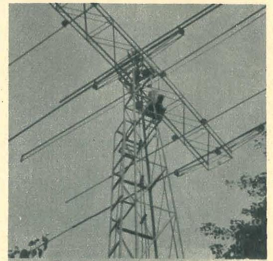
Vista parziale dell'antenna Rotary del posto G3 C1 Z di portata eccezionale. Con i suoi elementi - tre per l'onda di 10 m e tre per quella di 20 m - essa ha l'aspetto di un'antenna regolare.
