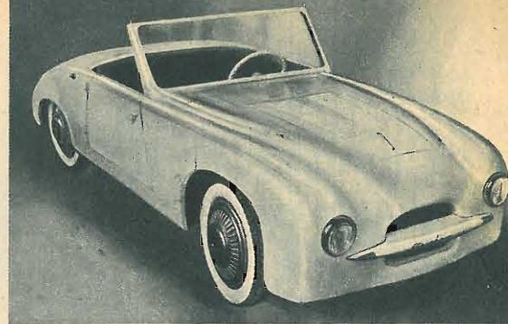
**DESHAÏS.** Motocar a 2 posti di moderna concezione. È a carrozzeria autoportante con motore a 2 cil, di 200 cc raffreddato ad aria; ruote anteriori motrici, freni idraulici; velocità massima 65 km/h.
