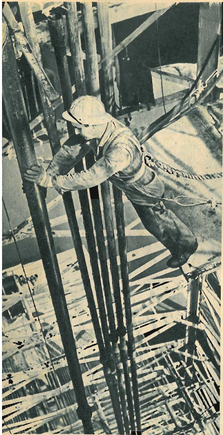
Per maneggiare da una piattaforma sopraelevata, l'estremità libera di un tubo di 40 m, questo operaio fa come uno scalatore.
