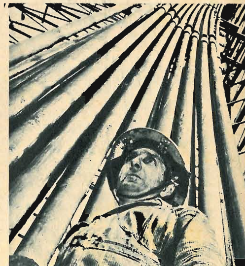
Man mano che la trivellazione procede gli spezzoni di tubi vengono calati un dopo l'altro.
