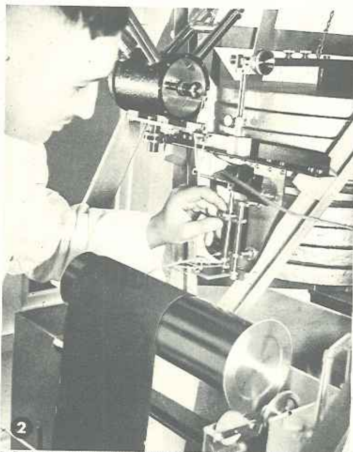
2. Parte registratrice di un sismografo a registrazione meccanica. In primo piano si vede la punta scrivente appoggiata sulla carta affumicata. Al centro, in alto, il dispositivo di smorzamento.
