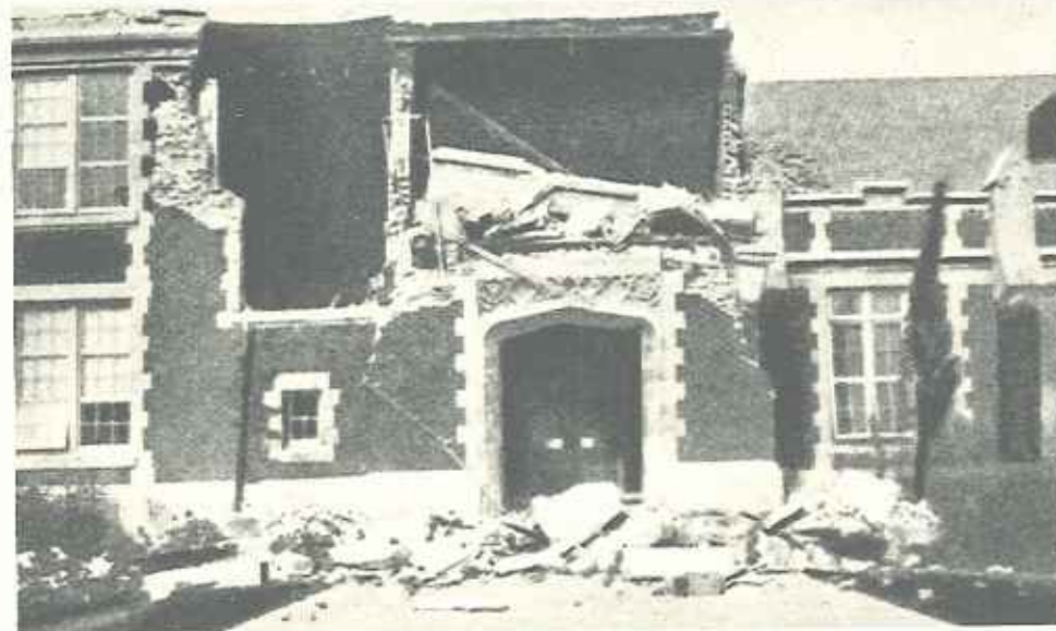
10. Due scuole, nella stessa città; il terremoto ha abbattuto quella male calcolata, ha lasciato intatta quella costruita correttamente. (Dal "Bulletin of the Seismological Society of America", Vol. 25, n. 3 del 1935.)
