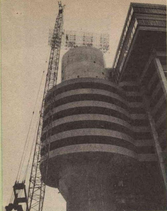
**È** stato installato recentemente sul tetto di un edificio all'aeroporto di Londra il nuovo radar S. 650 della Marconi (ved. foto). Si tratta di un congegno allo stato solido di dimensioni ridotte, che dispone però di un'antenna di 15,2 m di lunghezza e di 4,5 ÷ 6 m di altezza, operante a 591 MHz. L'antenna ha un ritmo di rotazione di 10,5 giri al minuto ed inoltre sviluppa una potenza di 160,9 km.
