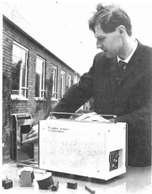
tografica Polaroid, con tempo d'otturazione di circa 1  $\mu$ sec; è perciò in grado di fotografare macchine rotanti, onde d'urto, ed anche il volo di proiettili.
