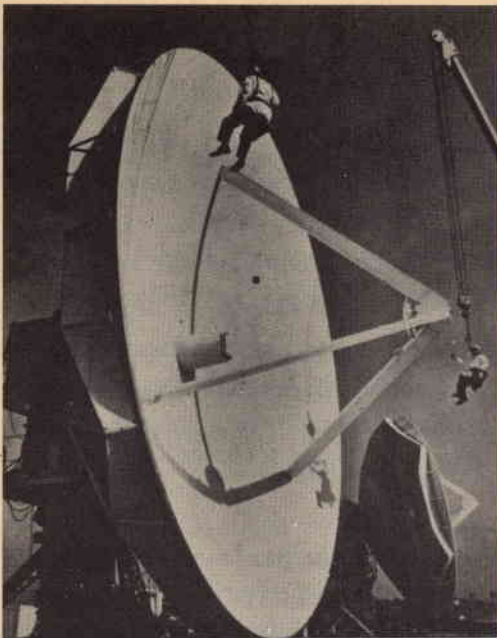
Come si vede dalla foto, per apportare le necessarie regolazioni alle antenne del diametro di 12 m, di cui sono dotate le stazioni di collegamento a terra Mark 1B, i tecnici si avvalgono di semplici seggiolini volanti tradizionali.
