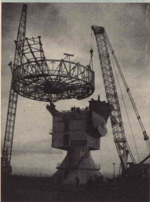
L'intera intelaiatura di acciaio (del peso di 35 t) di un nuovo radiotelescopio in costruzione a Chilbolton viene sollevata e sistemata nella propria sede mediante due potenti gru mobili.
