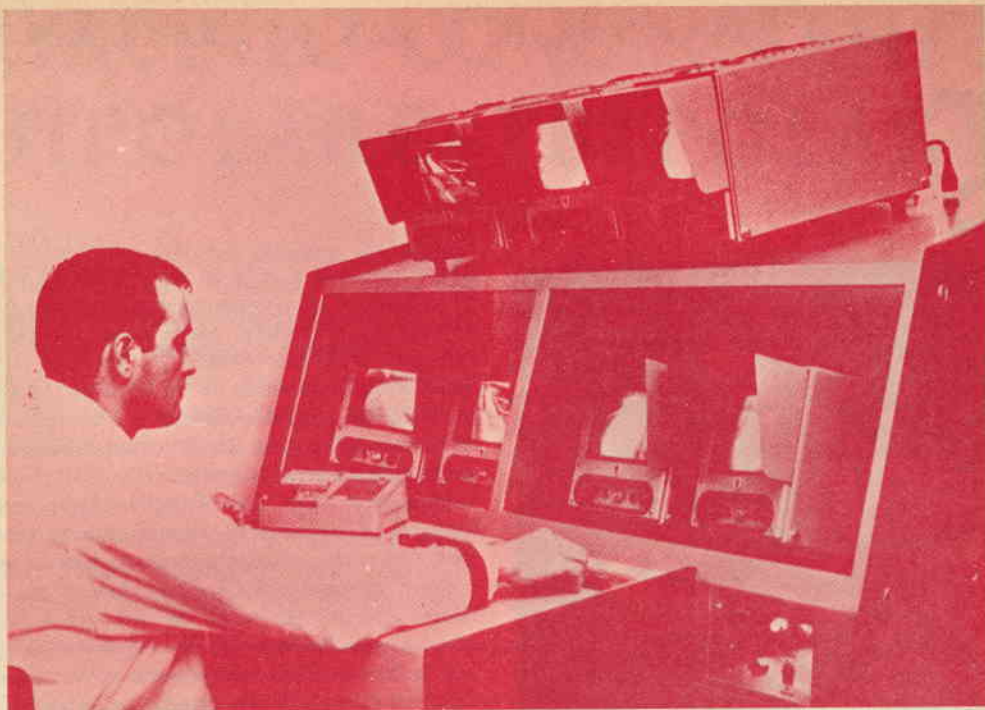
Posto di controllo centrale dell'impianto di televisione a circuito chiuso installato all'autodromo di Monza, tramite il quale è possibile seguire istante per istante lo svolgersi delle competizioni sportive.
