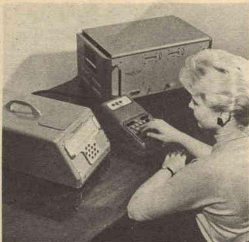
Questo apparecchio per sviluppare la capacità psicomotrice costruito dalla Rheem Manufacturing Company, è composto da tre parti, e comprende: un'unità a programmazione, una normale tastiera di calcolatrice IBM ed un'unità calcolatrice per effettuare il controllo.
