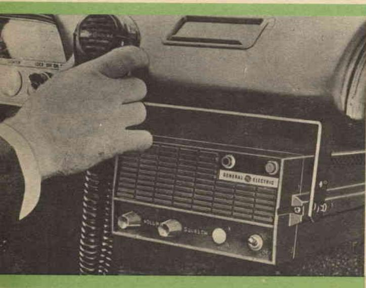
**R**adio rice-trasmettenti a bassissimo costo sono state costruite dalla International General Electric. Leggere e monoblocco, queste radio a 15 valvole e 2 transistori richiedono un consumo estremamente ridotto delle batterie e possono essere impiegate sulle lunghezze d'onda di 25-50 MHz e 150-174 MHz. Rispondono perfettamente all'uso delle onde ad altissima frequenza ed a modulazione di frequenza.
