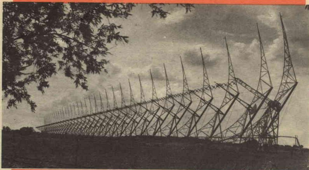
Il nuovo radiotelescopio interferometrico di Cambridge, ultimato nel 1958, aumenta il suo potere risolutivo grazie alle combinazioni di più osservazioni di una stessa sorgente fatte con diverse posizioni della parte mobile del sistema di antenne; la più lunga di esse (435 m) è fissa, mentre l'altra (57 m) è mobile su rotaio; il potere risolutivo è equivalente a quello di due antenne paraboliche da 225 m montate a 800 m l'una dall'altra. Questo telescopio avrà molti impieghi diversi.
