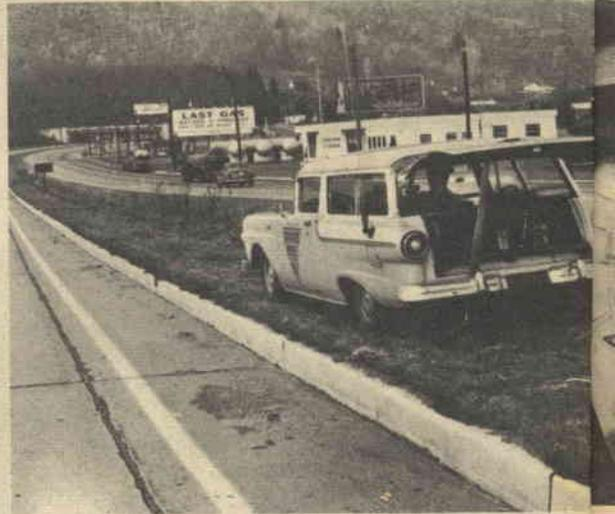
**1** Una scatola montata su un treppiede controlla ogni automobile sulla strada N° 17 a Mahwah (New Jersey); misura la velocità grazie al cambiamento della lunghezza dell'onda riflessa dalla macchina.
