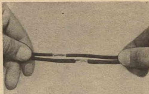
Per evitare cortocircuiti nelle giunture dei fili elettrici tagliate uno dei fili di cinque centimetri più corto dell'altro. Togliere poi via due centimetri di isolante dalle punte dei quattro fili collegando un filo corto e uno lungo. Questo metodo distanzia le connessioni isolandole l'una dall'altra. Una volta saldato e ricoperto di nastro, il giunto rimane sottile.
