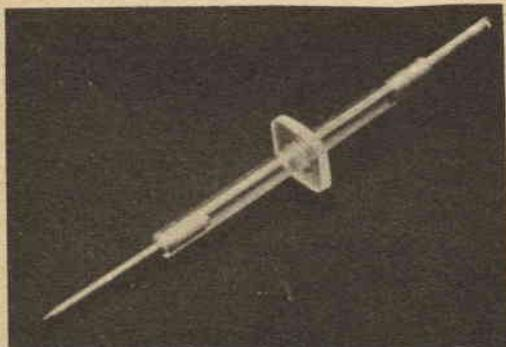
quadrato con lati di 2 cm e praticate nel centro un foro di diametro leggermente più piccolo di quello del manico dell'utensile; alesate o limate il foro in modo che in esso possa entrare forzato il manico dell'utensile. Applicare su entrambi i lati un po' di collante e lasciate seccare; gli spigoli acuti del pezzo di plastica si possono arrotondare con una lima.
