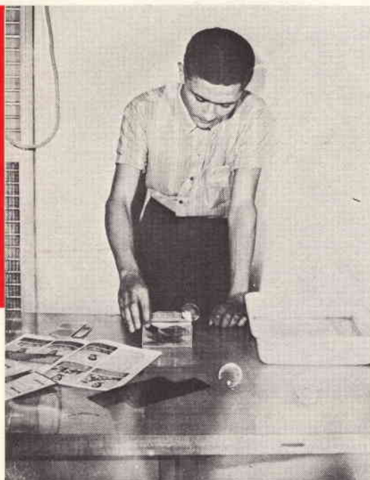
Fig. 8 - Per rinforzare una negativa, dopo averla abbondantemente lavata, la immergete nella soluzione ottenuta sciogliendo in un litro di acqua il contenuto del flaconcino piccolo. L'operazione si effettua alla luce. Ricordatevi di controllare che tutta la superficie della negativa risulti immersa nella soluzione.
