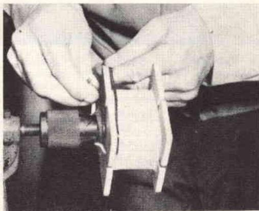
**Fig. 10 -** Per avvolgere il filo sul cartoccio, vi sarà di valido aiuto un trapano fissato ad una morsa. Nel mandrino fisserete un perno filettato in cui verrà infilato il porta cartoccio. Dopo aver fermato il tutto con un bullone, potrete iniziare l'avvolgimento.
