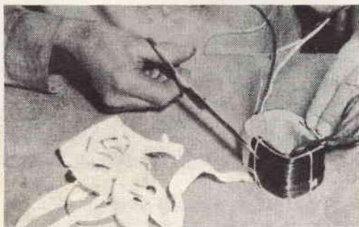
**Fig. 18** - Terminati gli avvolgimenti, dovremo ricoprire l'ultimo strato con due o tre giri di carta. Per quei lettori che sono soliti legare gli avvolgimenti con filo od avvolgere strati di tela, diciamo subito che tale sistema risulta praticamente superfluo per trasformatori radio fino a 500 Watt di potenza.
