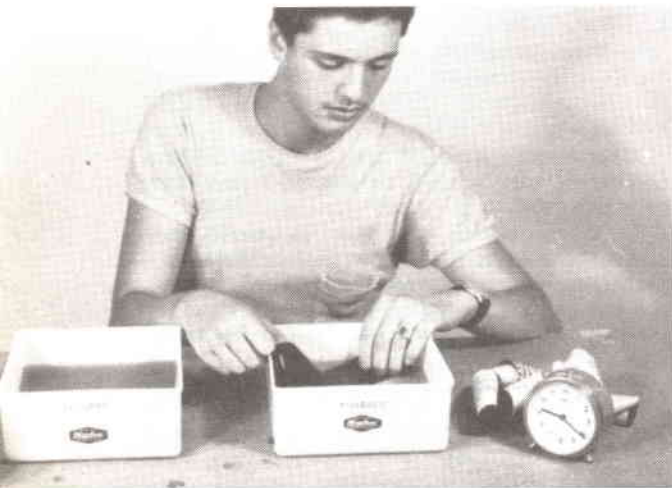
Fig. 11 - Anche nel bagno di fissaggio non trascureremo di muovere la pellicola prendendola alle due estremità, e facendo in modo che tutta la superficie venga progressivamente ed alternativamente a contatto con il liquido di fissaggio.
