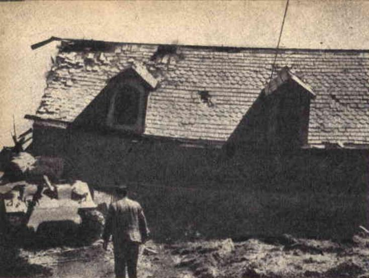
Nonostante il suo aspetto minaccioso, il carro armato « Sherman » della foto non è altro ormai che un pacifico strumento impiegato per opere di demolizione; il suo cannone da 75mm. funge da ariete.
