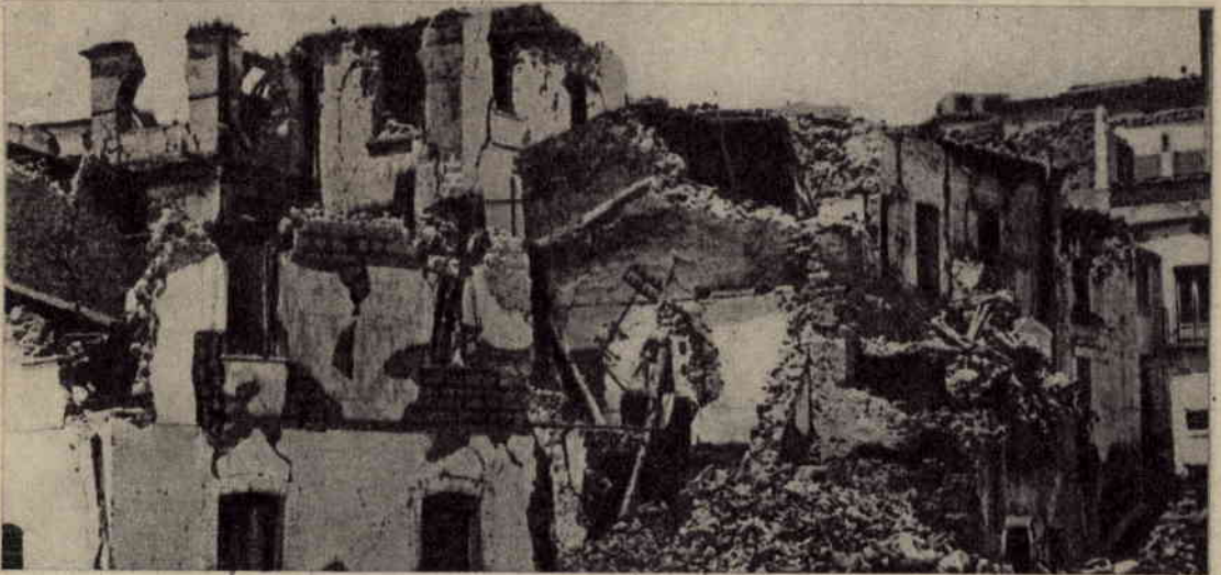
Sopra: Effetti di un terremoto su una casa mal costruita. I muri, formati di ciottoli mal legati, sotto l'impulso di varie scosse si sono completamente sfasciati, rovinando. Sotto: Grafico di un terremoto locale sensibile all'uomo: A = ipocentro; B = epicentro; E = profondità dell'ipocentro; C = area misosismica; F = area macrosismica; H = area microsismica; R = area telesismica; K = crosta terrestre.
