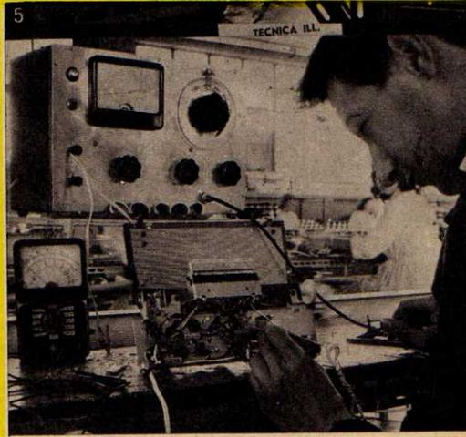
Dopo 5 successivi passaggi in cui vengono collegati gli zoccoli e i trasformatori di alimentazione e quello di uscita, si arriva a questa fase di lavorazione. Qui vengono montati il cavo di alimentazione e i primi conduttori.
