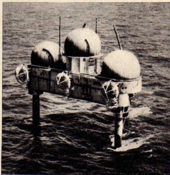
A sinistra: Una tipica « isola dell'olio ». Essa è praticamente una piattaforma saldamente ancorata al fondo del mare e su di essa sono impiantate torri di perforazione per lo scavo di pozzi petroliferi sotto il mare. A destra: Un'isola « radar ». Le apparecchiature-radar per le varie determinazioni, sono ricoperte da tre grandi cupole che hanno lo scopo di proteggere le antenne dalle intemperie.
