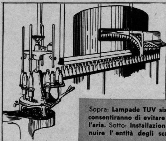
**Sopra: Lampade TUV sistemate sopra i trasportatori di bottiglie sterilizzate, consentiranno di evitare le contaminazioni da parte dei germi contenuti nell'aria. Sotto: Installazione di lampade TUV in una cella frigorifera per diminuire l'entità degli scarti causati dallo sviluppo di muffe e di batteri.**
