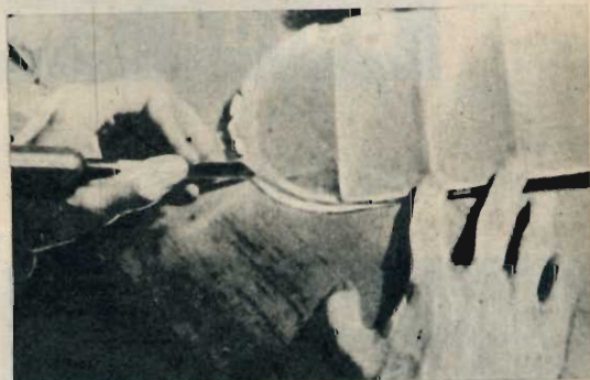
Fig. 12 - Trattamento della carta nei terminali.
