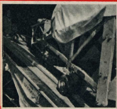
Sopra: Per salire e scendere dal « ventre » dell'aereo, il missile vien fatto scorrere su di un carrello guidato da una rotaia. Sotto: Dopo 20 ore di volo, il Thor ha finalmente raggiunto la torre della sua base di lancio.
