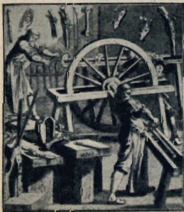
A sinistra: Antica bottega di un armaiolo. Il maestro armaiolo in primo piano sta fermando una canna grezza nella morsa. A destra: Si danno gli ultimi tocchi alla parte inferiore di una montatura.
