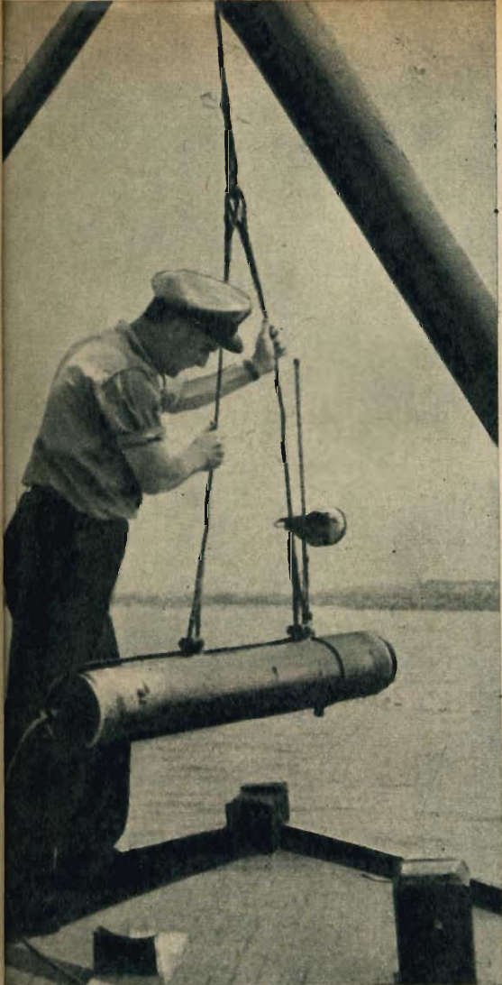
Pronta per il tuffo un'unità per telecamera del peso di circa 70 kg. viene portata fuoribordo. La incastellatura impermeabile è di acciaio inossidabile. L'apparecchio di illuminazione è fissato sulla sbarra verticale. In alto a destra: Disegno schematico verticale. In alto a destra: Disegno schematico delle varie parti di cui è composto il robot-televisivo.
