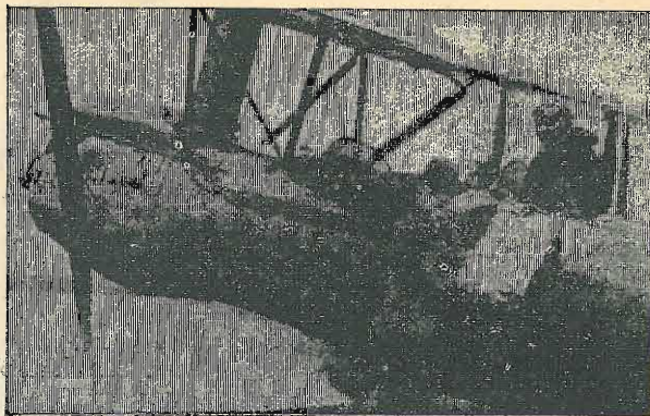
Fotografia trasmessa a distanza per mezzo dell'elettricità. La figura osservata con una lente d'ingrandimento appare costituita di una serie di linee verticali più o meno marcate a seconda del chiaroscuro. Mentre, com'è noto, i comuni clichés sono costituiti di una serie di punti analogamente più o meno marcati a seconda che occupino lo spazio delle ombre e delle luci.
