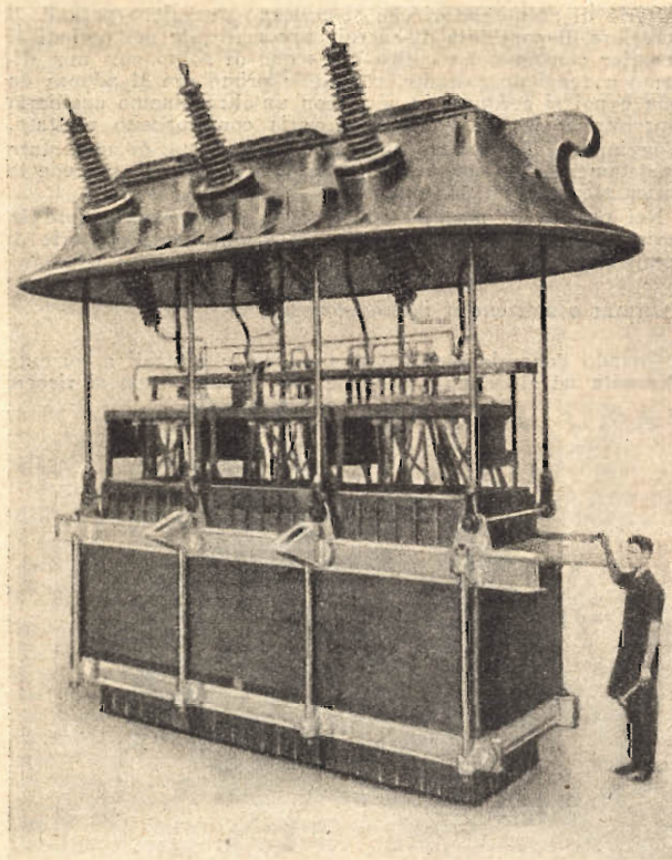
Fig. — 7. Trasformatore trifase ad olio 10000 Kw. — 100 000 Volts — estratto dalla sua cassa.
