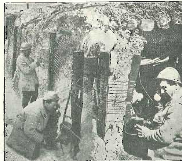
Telefonisti francesi comunicanti dalle trincee col centralino, ponendo i loro apparecchi mobili in derivazione sulla linea.
