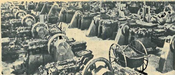
A sinistra: una batteria di macchine automatiche che ingoiano filo d'acciaio e sputano chiodi alla velocità di 550 al minuto primo.
