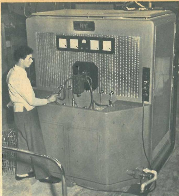
**Saldatura per punti** effettuata da un nuovo forno ad alta frequenza presentato dalla FIAT alla Mostra della Meccanica. La saldatura elettronica permette la rapida giunzione di elementi metallici.
