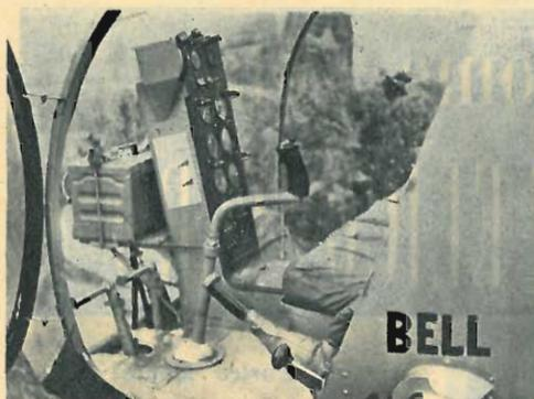
Sopra: I comandi a disposizione del pilota; il pomello in primo piano comanda il rubinetto della benzina; subito dietro è la leva a manopola girevole che comanda il gas al motore e il passo «totale». La leva d'angolo comanda l'inclinazione del rotore; la pedaliera, il passo dell'etichetta di coda. Sotto: tutti i congegni illustrati nel disegno a sinistra della pagina seguente. In più si vedono un contrappeso statico e ammortizzatori collegati alle sbarre,
