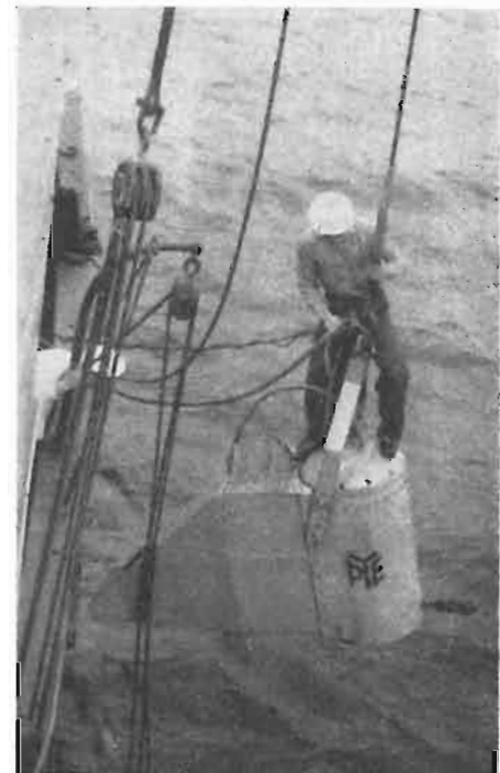
La telecamera nel suo involucro stagno a pressione, viene calata in mare.
