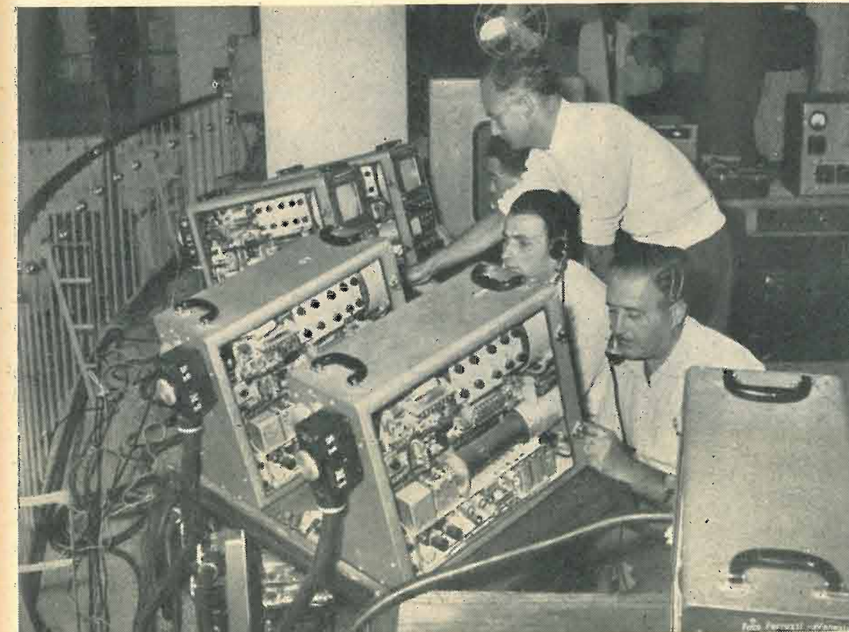
Le apparecchiature di controllo delle trasmissioni TV della RAI al Palazzo del Cinema al Lido di Venezia.
