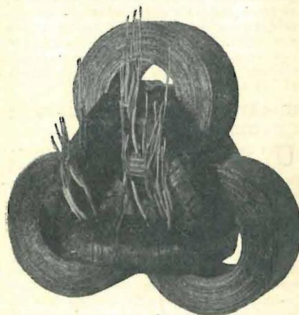
Fig. 11. - Trasformatori trifase con tre nuclei avvolti a fasi perfettamente equilibrate.
