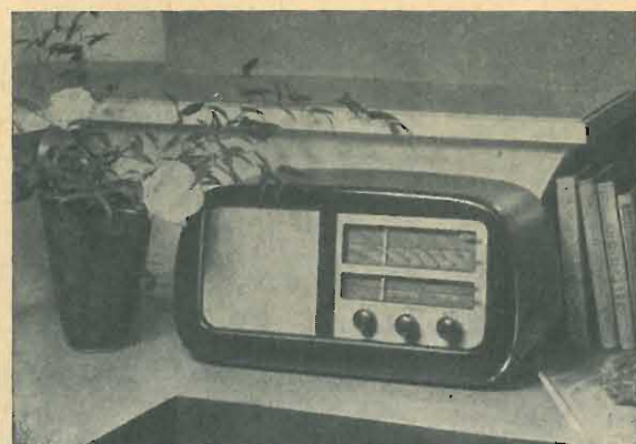
Mod. 540 5 valvole, 4 gamme, sintonia a permeabilità variabile
