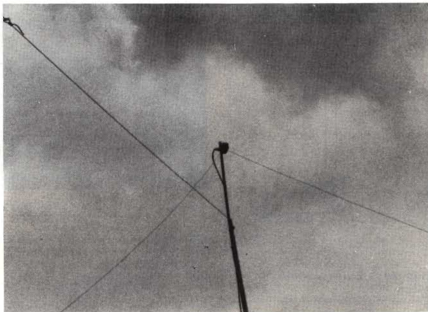
Foto 1. La MDS è un'antenna poco appariscente. Il punto di collegamento tra linea di alimentazione e antenna è stato protetto con un involucro in plastica, sigillato con silicone. Il filo che va verso l'angolo in alto a sinistra fa parte di un'antenna diversa dalla MDS.
