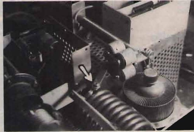
⑮ "Chiudendo il pannello centrale ribaltabile è ora possibile, con una semplice vite (indicata dalla freccia) connettere il  $\pi$  d'uscita ai 4 condensatori da 500 pF/20 KVL".
