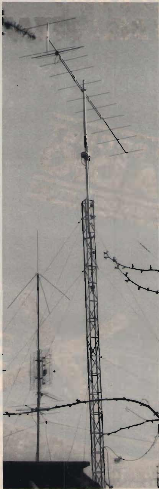
Il traliccio completo sul terrazzo. Notare i molti tiranti che ne assicurano la stabilità. Tutto è a posto: si comincia a trasmettere!
